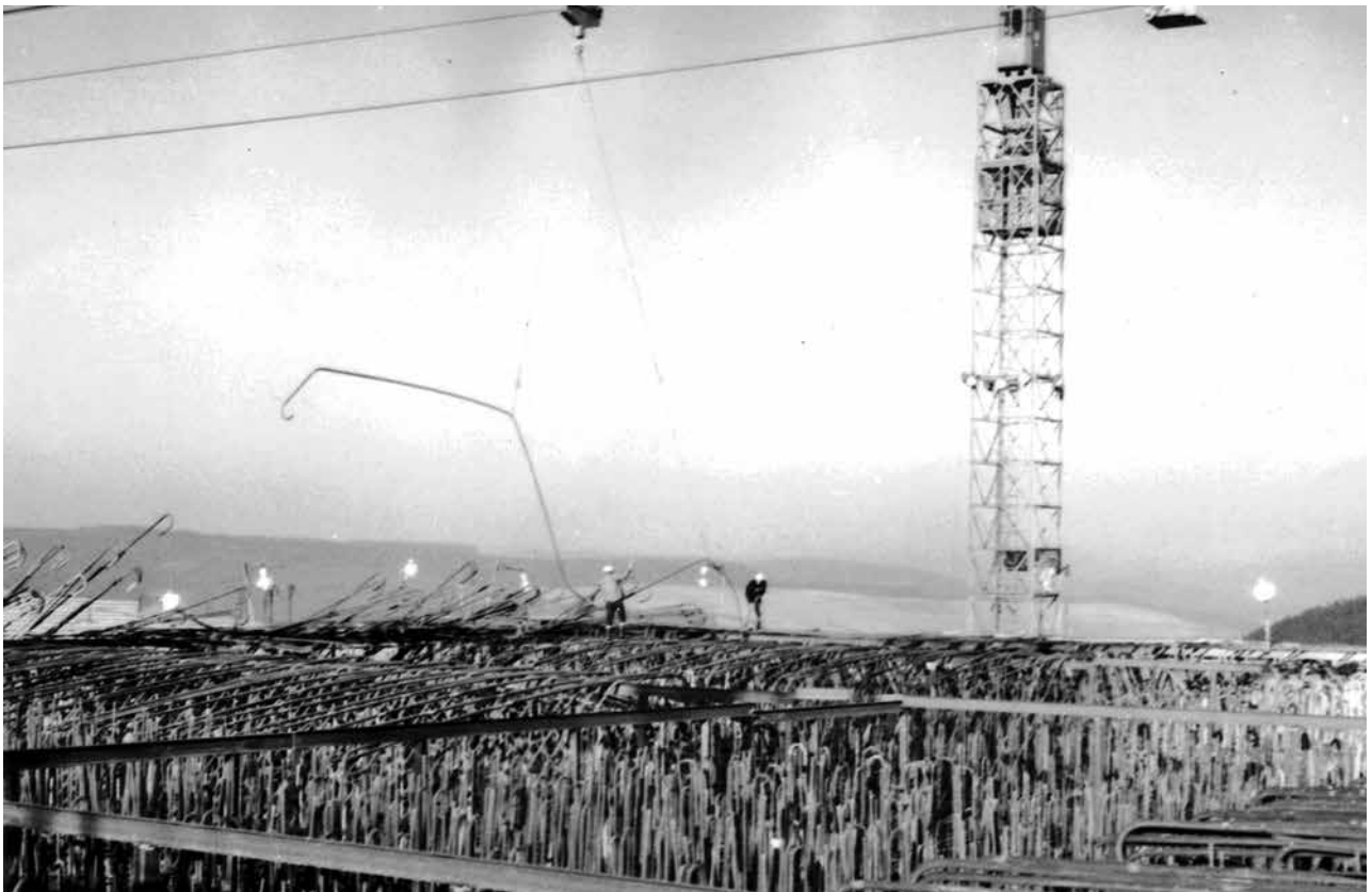
Bewehrung der Abschlussdecke, Ende 1963
