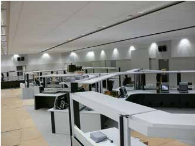
Im März 2010 ist die Einrüstung in vollem Gange. Die KOFA-Anlagen stehen schon an den Arbeitspositionen
