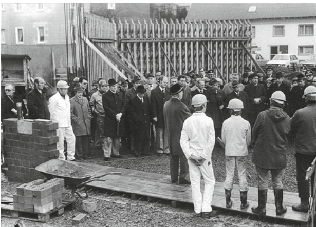
Der Anfang ist gemacht: Baubeginn für das „Haus Wittgenstein“
