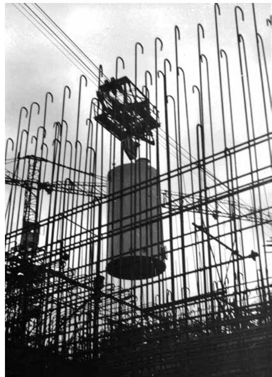
Einbringung von Behältern, Ende Oktober 1963
