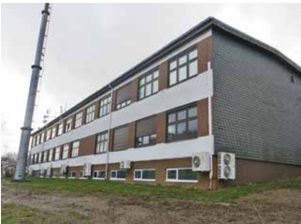
Außenansicht auf Block 8. Zwischen 1998 und 2011 befand sich hier das Interims-CRC, seit der Verlegung des Einsatzbetriebes in Block 49 wird das Gebäude als ATT genutzt.
