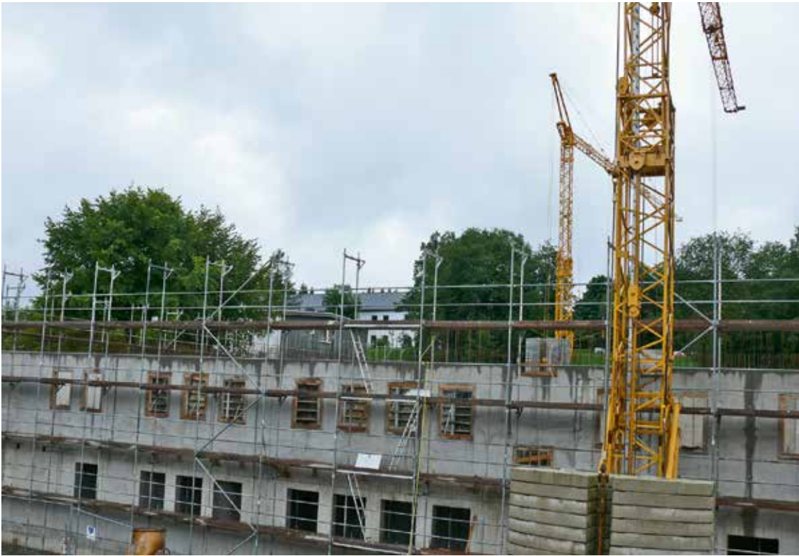
August 2008: Der Rohbau wächst in die Höhe...
