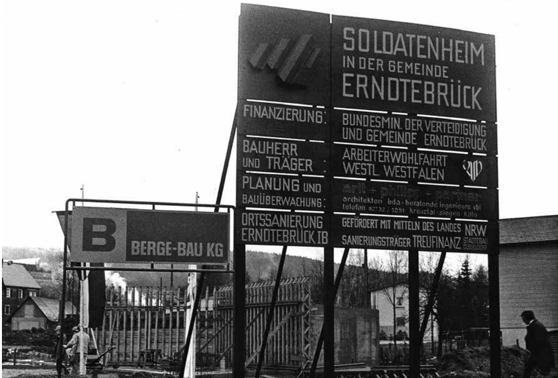
Baugelände im Zentrum von Erndtebrück
