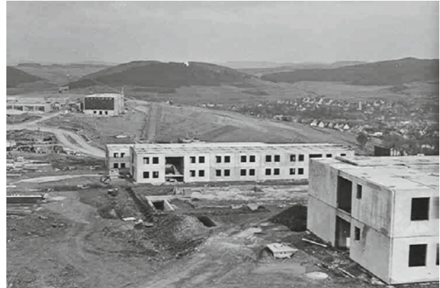
Baustelle auf dem Hachenberg 1964
