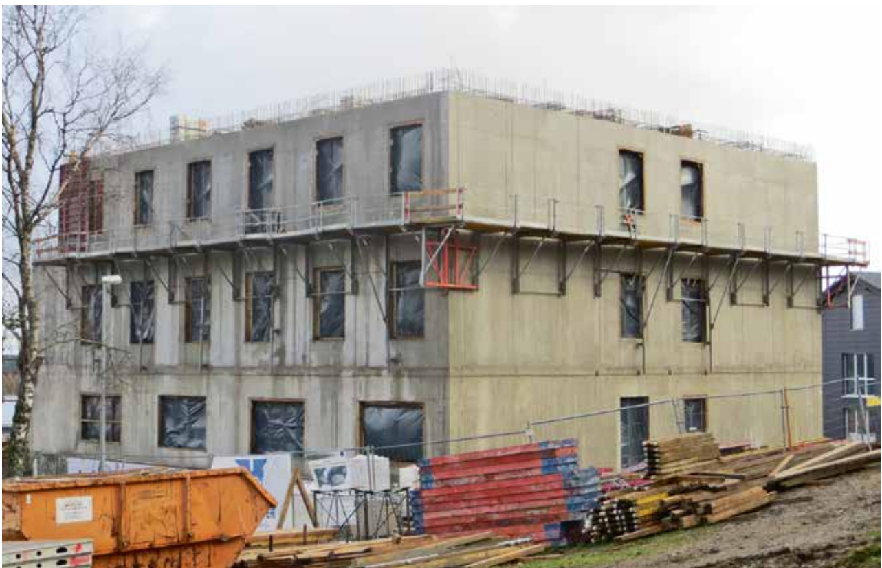
Baustelle der neuen ATT im Dezember 2015
