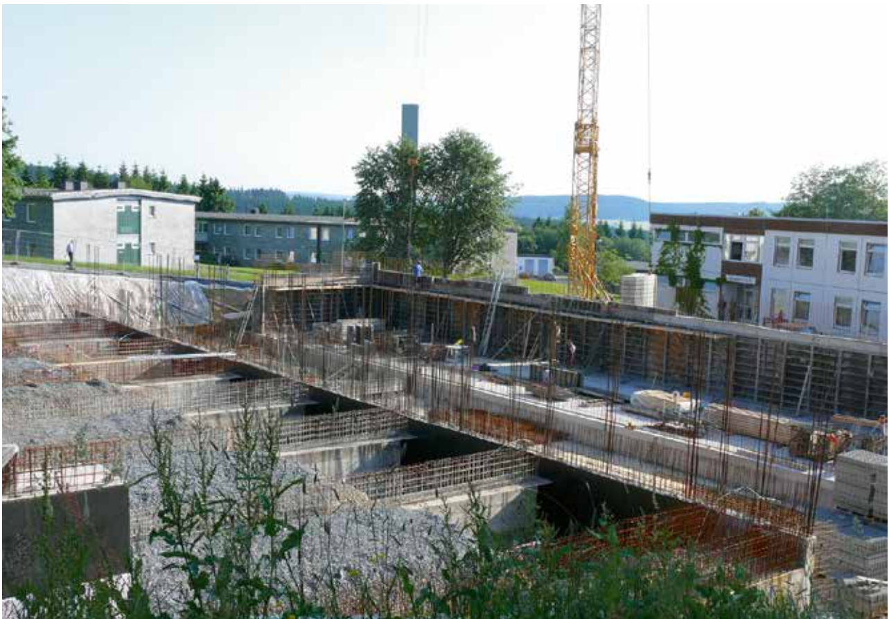
Die Baustelle des neuen Einsatzgebäudes in der Hachenberg Kaserne im April 2008
