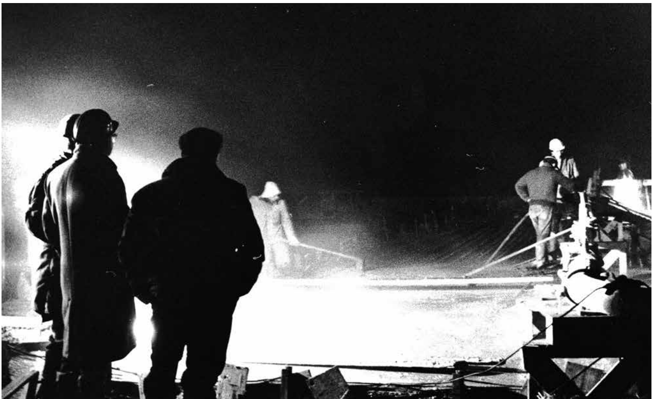
Deckenbetonierung bei Nacht, Januar 1964
