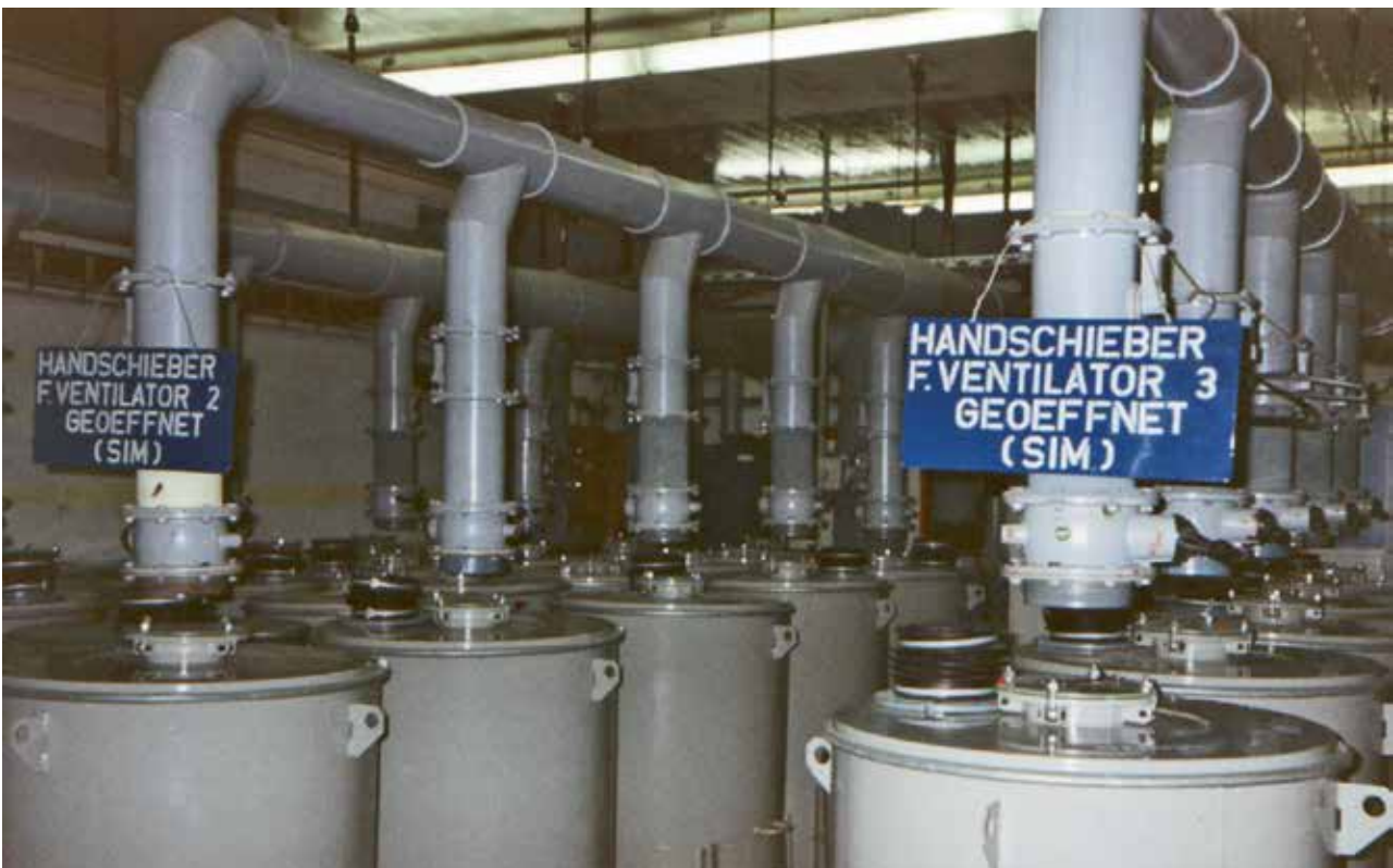
Die ABC-Filteranlage
