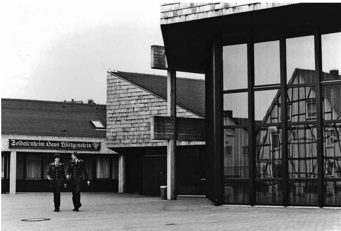
Das fertige Soldatenheim im Zentrum von Erndtebrück
